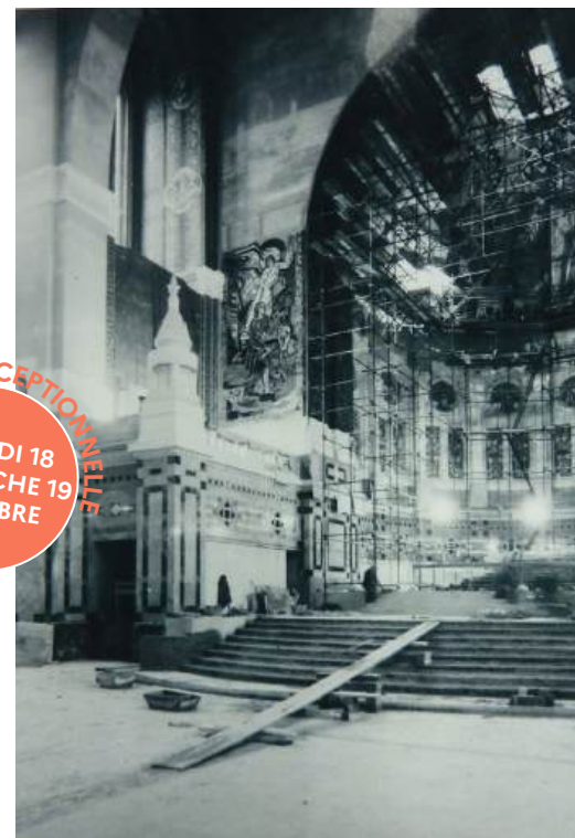
Photo du chœur en chantier © archives Gaudin, tous droits réservés
